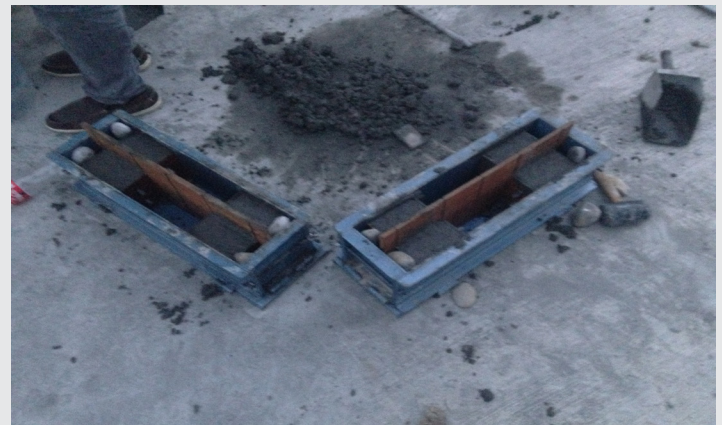
Figura 2.3. Elaboración de vigas de concreto reforzado.
